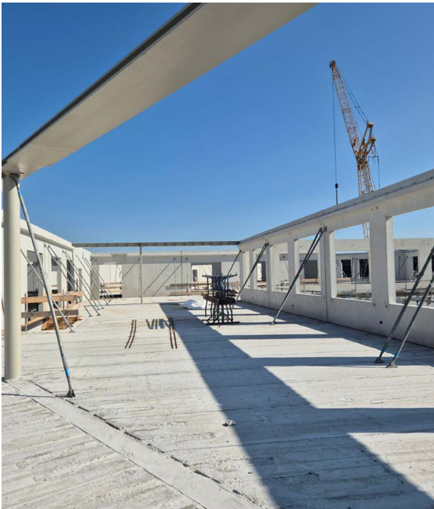
Omdat het gebouw vrij uitgestrekt is, was een juiste montagevolgorde van de wanden, vloeren en stalen onderdelen essentieel.
