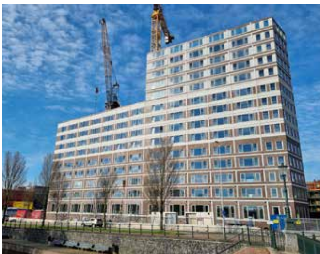
Bijzonder aan het woongebouw zijn de markante uitstraling en grote variatie aan woonplattegronden, in combinatie met de prefab bouwwijze.
