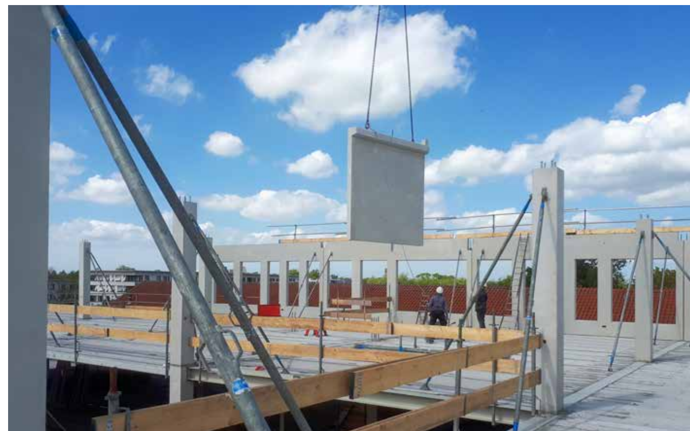
Voor de Beroepscampus in Middelharnis heeft Stabiel Management een heel open en flexibel bouwcasco uitgewerkt.
