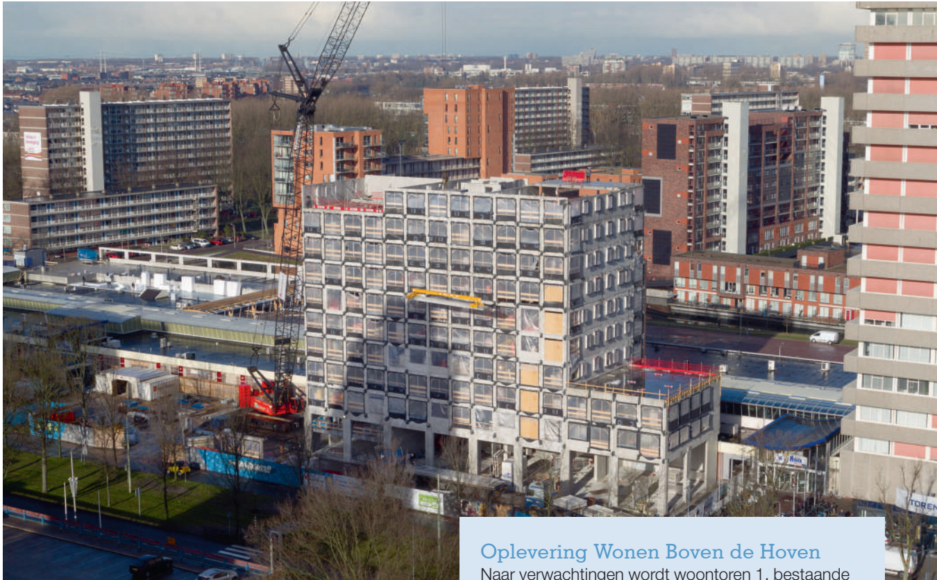
De nieuwbouwtoren in aanbouw. (Fotografie: VBI)
